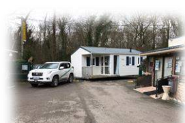
Transport et mise en place de Mobil-Home
