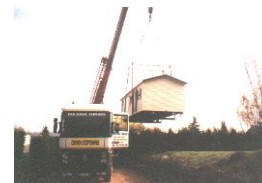
Transport et mise en place de Mobil-Home
